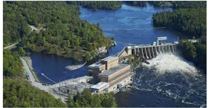
Crédit photo: Hydro-Québec
