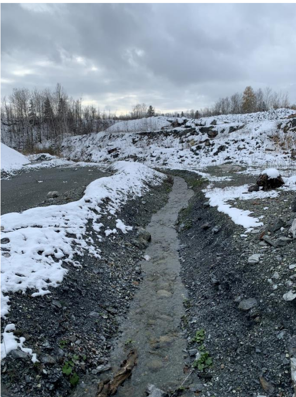
Figure 60 : Exutoire, mine Nationale
